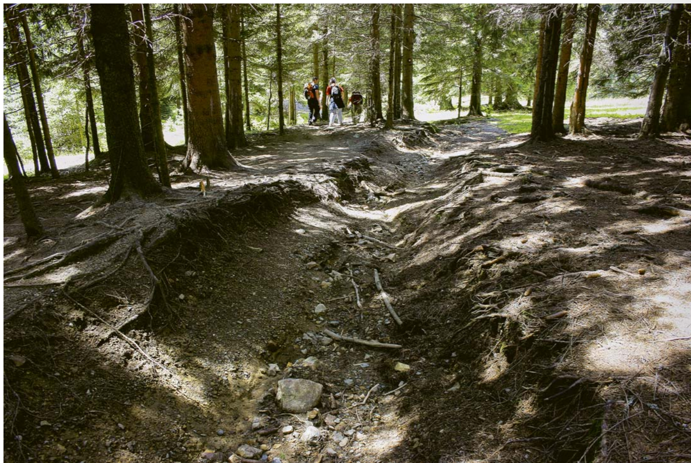
MOČNO ERODIRANA IN UGREZNJENA PLANINSKA POT S POŠKODOVANIMI KORENINAMI TER VIDNO KAMNINO
